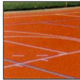
4. Schützen und Erhalten von bituminösen Belägen Seite 10 – 11
